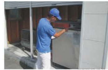
取引先設備確認の様子
