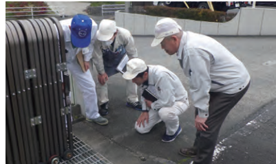
取引先様立ち会ひのもと最終排水溝確認の様子
