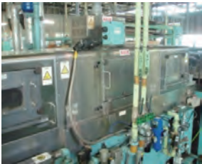
断熱材貼り付け前
