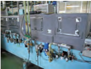
断熱材貼り付け後
